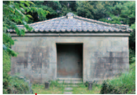
⑦ 御霊泉口 (常磐蔵) (外壁 590 × 1000cm)
